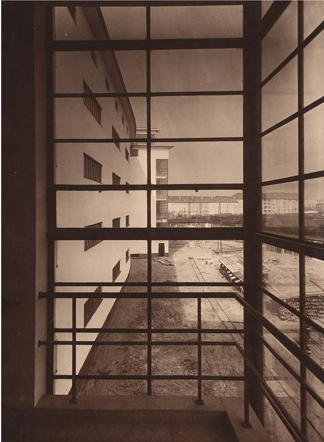
Blick aus dem treppenhaus 1931
