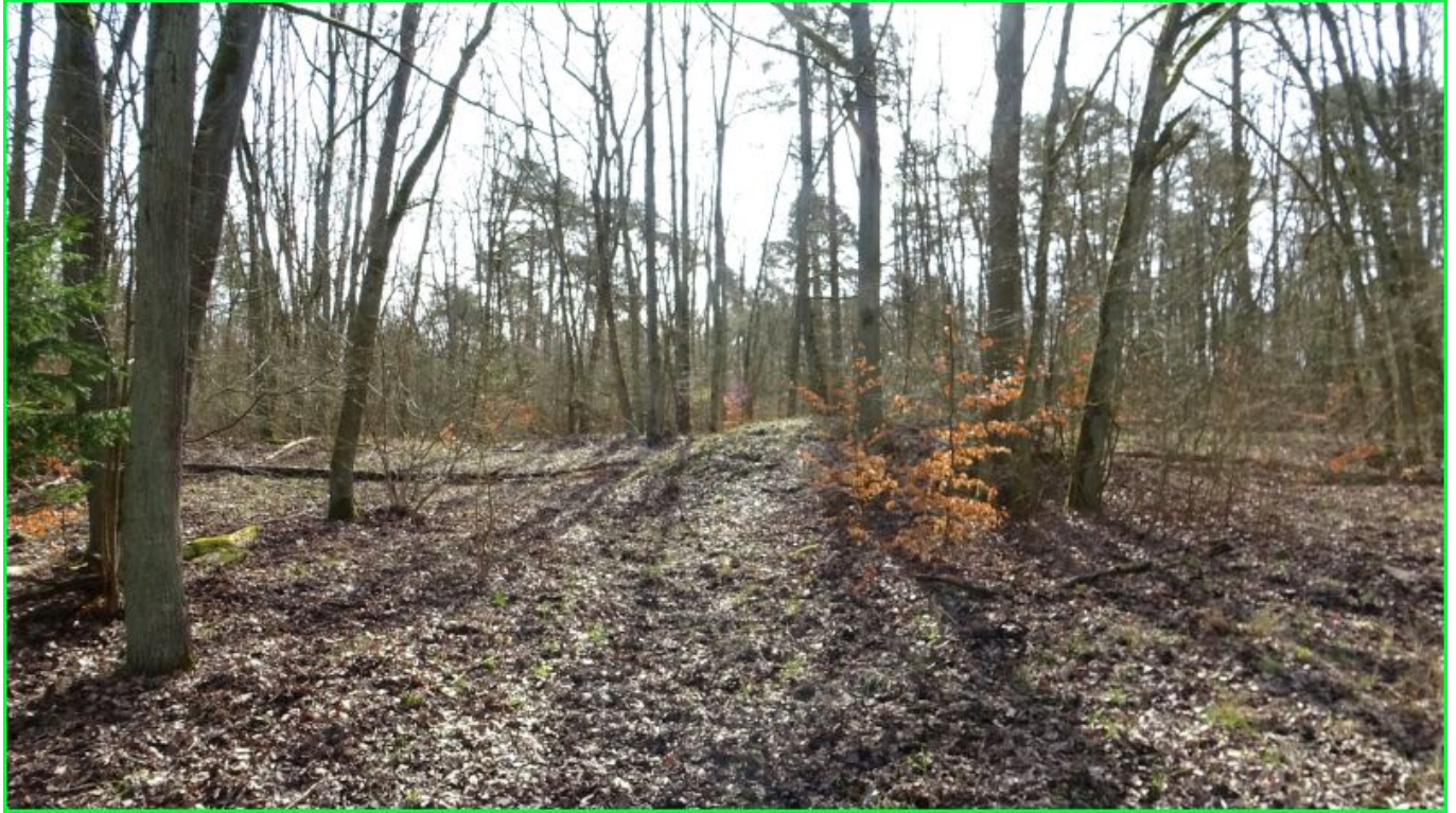
Blick auf Bahndamm quer
